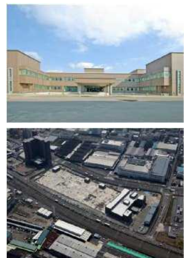
図 H22年度に供用を開始した 竜華水みらいセンター (処理方式：生物学的脱リン+ステップ流 入式2段硝化脱窒法+生物膜ろ過)
