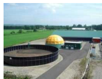
【メタン発酵施設】
