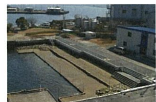
護岸の前面に階段状の干潟を整備(横浜港)
