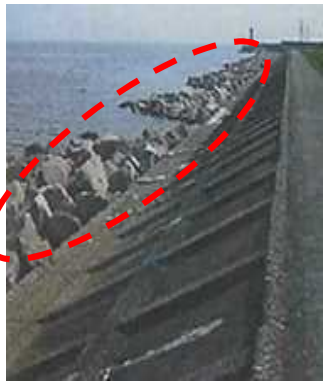
巨石の設置状況 (近傍)
