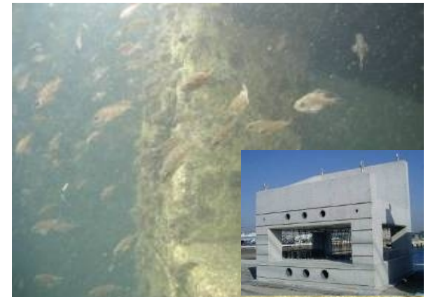
泉大津沖埋立処分場のエコ護岸
