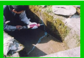
■ 末端水路の補修
