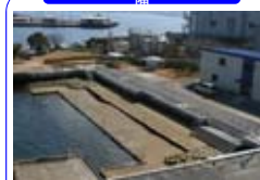
護岸の前面に階段状の干潟を整備 (横浜港)
