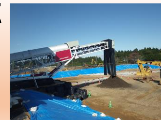
中間貯蔵施設 土壌貯蔵施設
