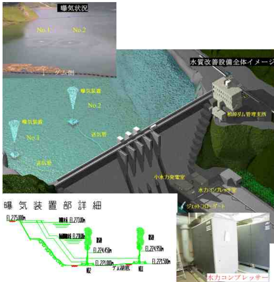
図 6.3.6 松原ダム貯水池水質改善設備（ばっ気装置）
