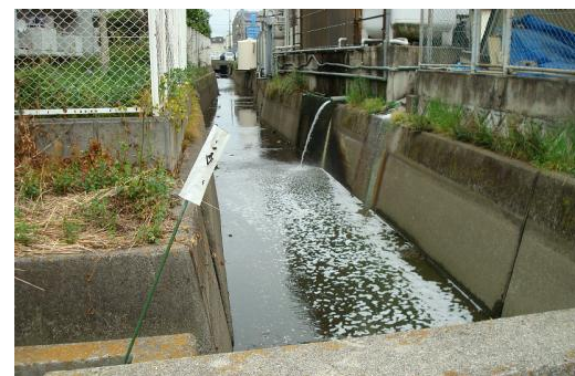
未規制の小規模事業場からの排水状況
