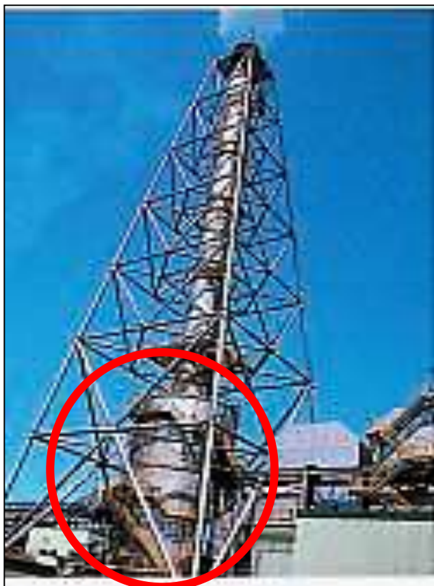
<湿式脱硫設備(外観)>
