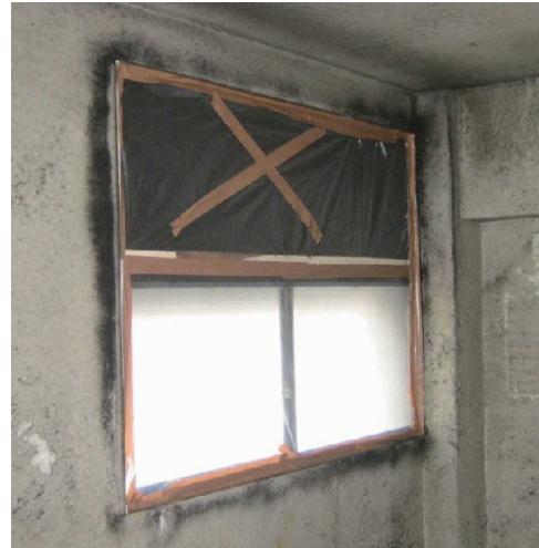
図 3. 27 窓、換気口の養生例
