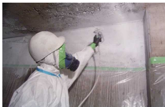
図 3. 70 除去した後の下地面への粉じん飛散防止剤の散布
