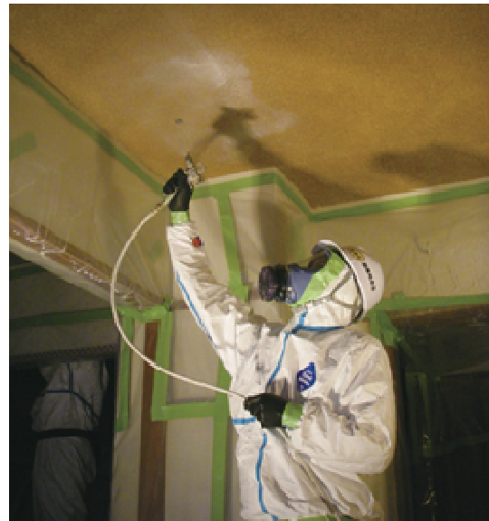
図 3. 63 粉じん飛散抑制剤の散布による湿潤化
