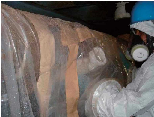
図 3. 98 石綿除去作業中 2
