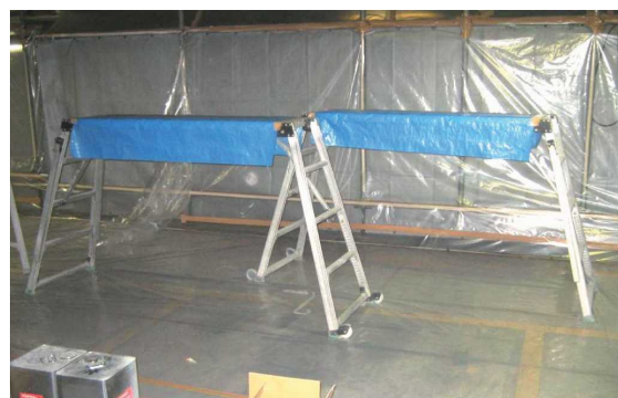
図 3.54 可搬式作業台の例
