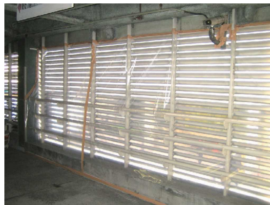
図 3.38 外壁の隔離例（ガラスの手前をプラスチックシートで隔離）
