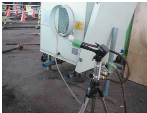
図 3.93 環境測定（作業中）
