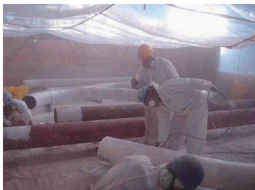
図 3.91 掻き落し作業
