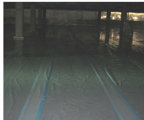
図 3.24 床面の隔離養生例（2重張り）
