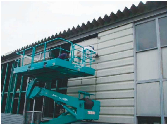
壁金物取外し
