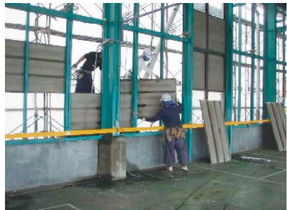
壁石綿含有成形板取外し
