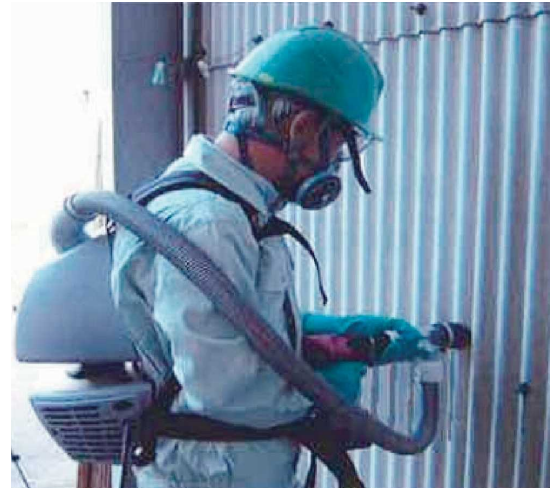
図 3. 111 機械工具による切断例
