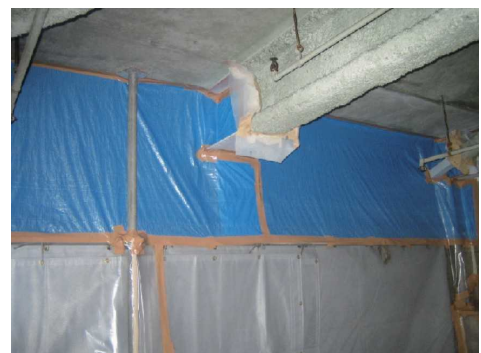
図 3.25 壁面の隔離養生例（作業場内側）
