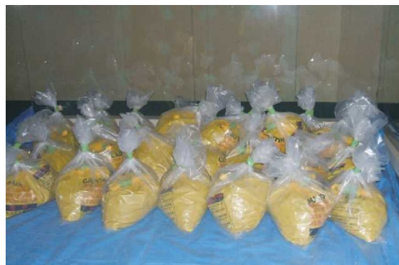
図 3. 69 除去した石綿廃棄物の一時保管
