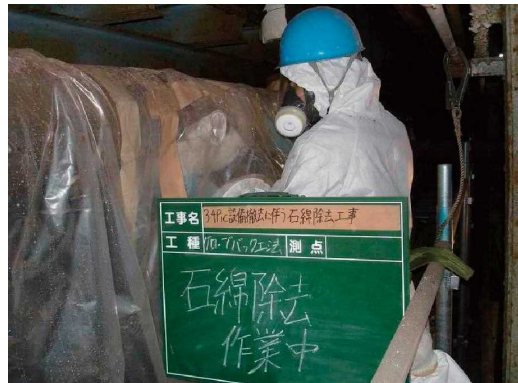
図 3.97 石綿除去作業中 1
