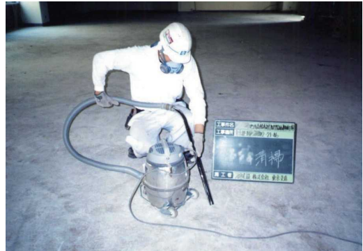
図 3. 115 清掃 高性能真空掃除機使用例
