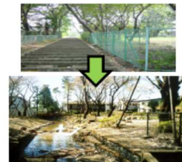
河川と公園との一体的な再整備
