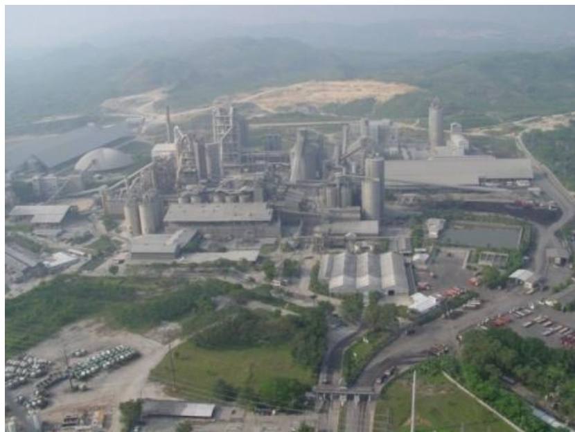
インドネシアのセメント工場
