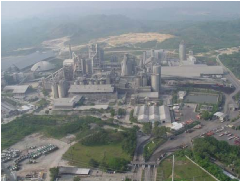
インドネシアのセメント工場
