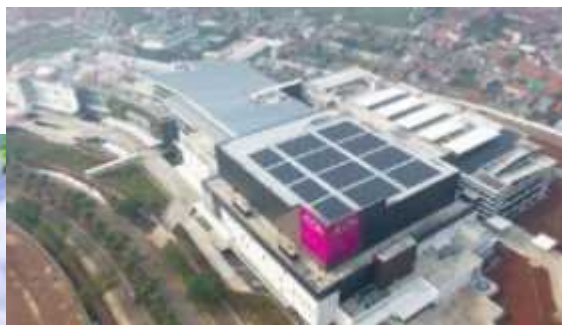
↑イオンモール屋上に設置された太陽光パネルと蓄電池システム
