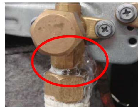
点検による漏れの確認
