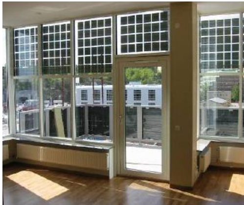
日射確度で伸縮するパネル(上)、「ひさし」になる太陽光パネル(左下)、 パネルで室内への日射を抑える(右下)。
