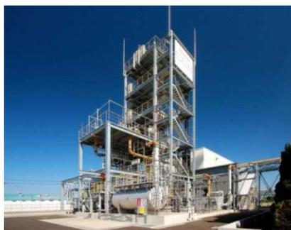
石炭火力発電所に設置された二酸化炭素分離回収設備
