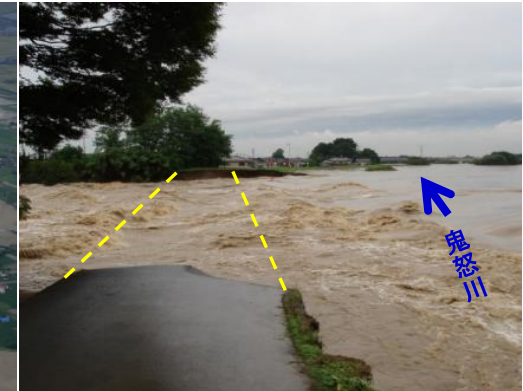
被災状況(拡大写真)
