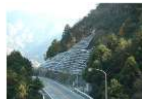
斜面崩壊防止対策
