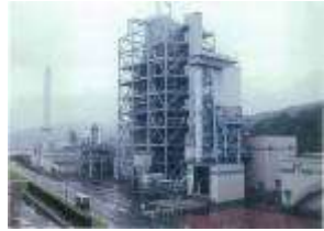
【電源開発(株)の多目的石炭ガス製造技術】
