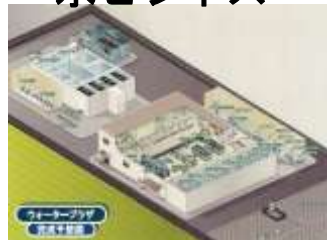
ウォータープラザ 下水の膜処理と海水淡水化 を組み合わせた水再生実証 プラント(日明浄化センター)
