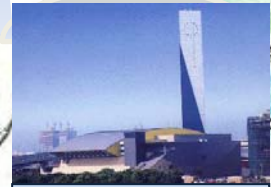
廃棄物焼却施設での廃棄物熱回収の促進
