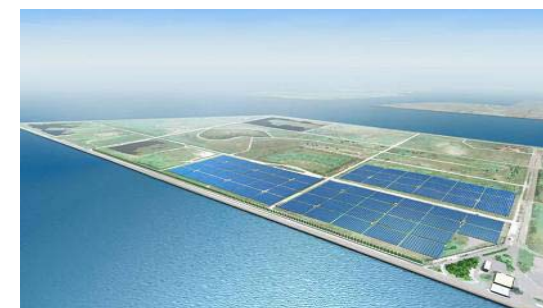
<堺第7-3区太陽光発電所（仮称）> 【関西電力】
