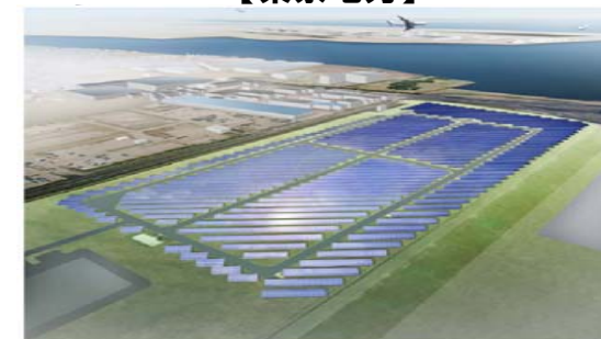
<浮島太陽光発電所（仮称）> 【東京電力】
