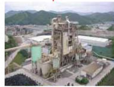
●2号発電設備 循環式流動層ボイラーで石炭の他、多種多様な燃料が使用可能です。
