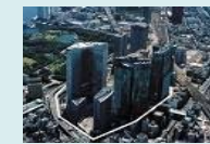
再開発を機とした地域冷暖房の導入
