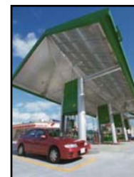
バイオエタノール混合 ガソリン(E3等)製造設備
