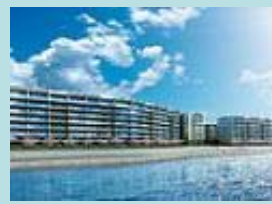
太陽熱供給システムを導入した集合住宅の整備
