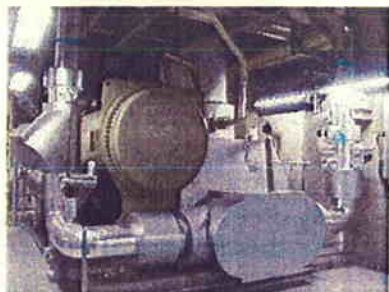
空調用 大型ターボ冷凍機
