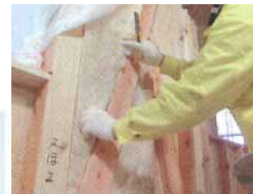
外壁・天井裏の断熱
