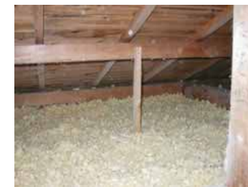
外壁・天井裏の断熱
