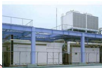
コージェネレーションシステム
