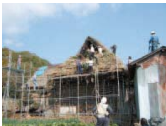
古民家の笹屋根の葺き替え
