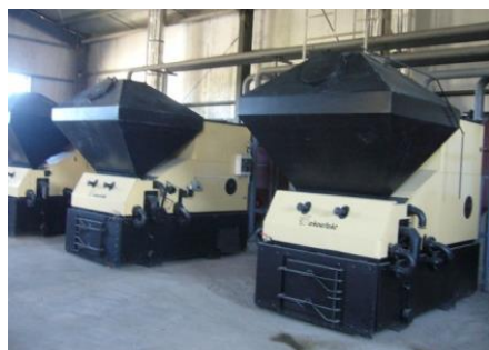
暖房用の高効率ボイ ラー(数理計画／モンゴ ル)サイト①
