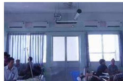
高効率エアコン及びEMS (三菱電機／ベトナム)
