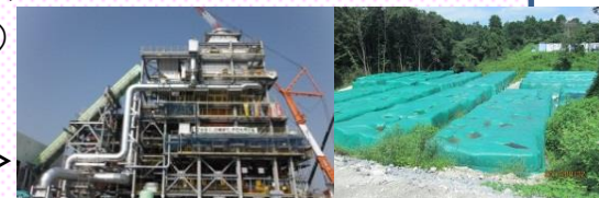
仮設焼却炉の建設状況 (対策地域内廃棄物)
