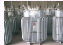
PCBが含まれる 高圧トランス
