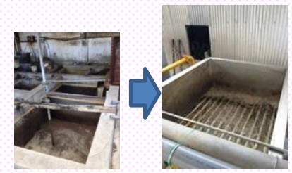
既存の排水処理槽
