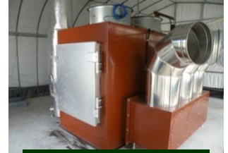
木質バイオマス利用 加温設備
