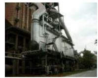
写真左： 電力会社に高効率配電変圧器を導入
