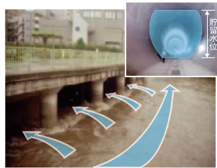
洪水調節施設(地下調節池) (出典12より)
