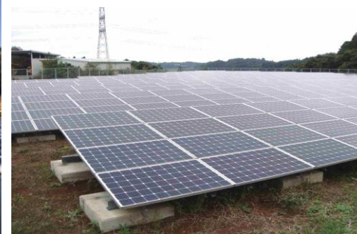
廃棄物処分場
