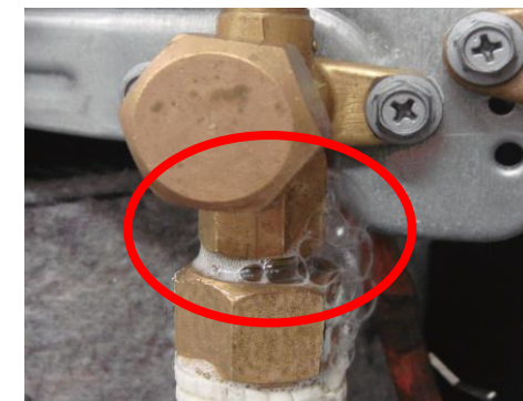
点検による漏れの確認
