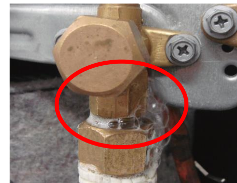
点検による漏れの確認
