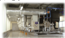
<中央方式冷凍冷蔵機器>
