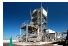
二酸化炭素分離回収設備
