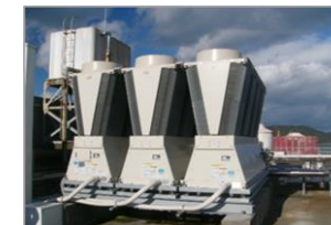
高効率空調設備 （チリングユニット）
