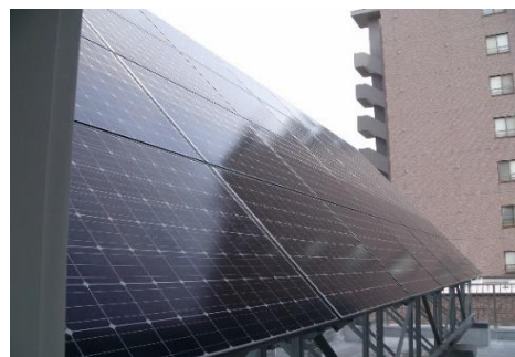
太陽光発電設備
