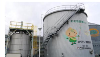
バイオガスプラント全景
