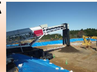
中間貯蔵施設 土壌貯蔵施設
