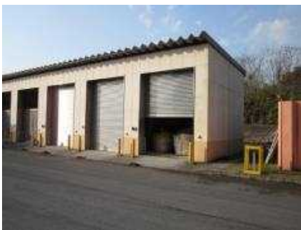
写真 2.4.1 保管庫の外観の例
