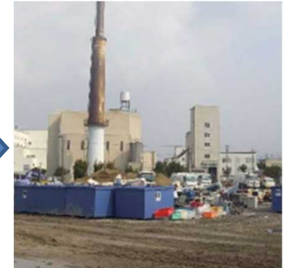
コンテナ設置後
