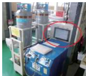
ポンベ重量監視システム
