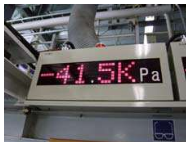
冷凍回路内の圧力表示
