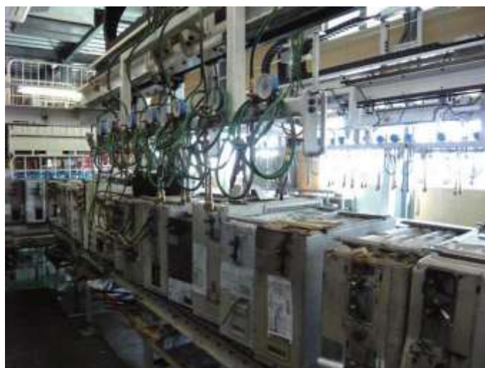
エアコンの冷媒フロン回収ライン
