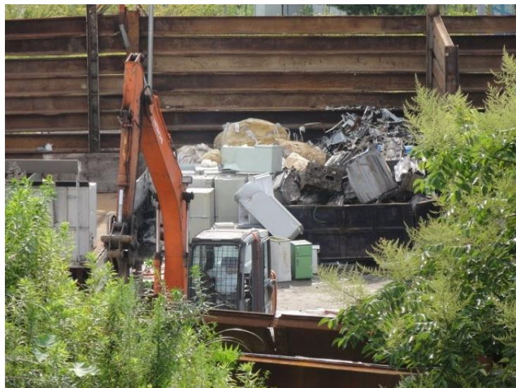
ヤードで冷蔵庫を破壊
