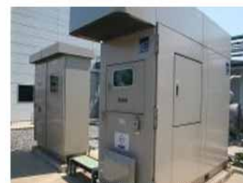
【マイクロガスタービン発電機】
