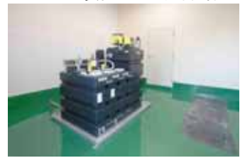
PH処理装置・油水分離槽
