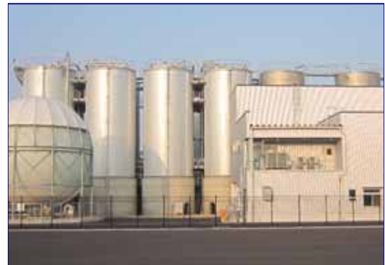
メタン発酵槽 6.0m×H18.5m×16槽
