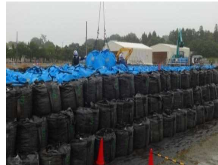
保管場への定置作業
